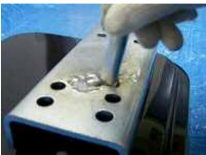
◆加熱した面の温度が下がらないうちに、本製品を施工部に押し広げて、亜鉛コーティングの皮膜を形成してください。
